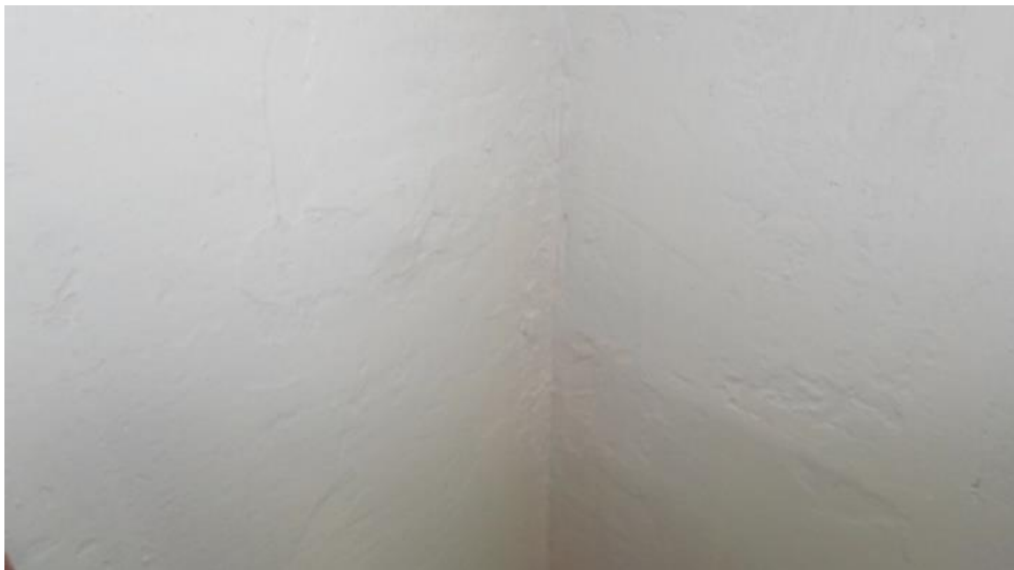
шероховатости, раковины, отслоения шпатлевочного состава, неровности и потеки раствора
