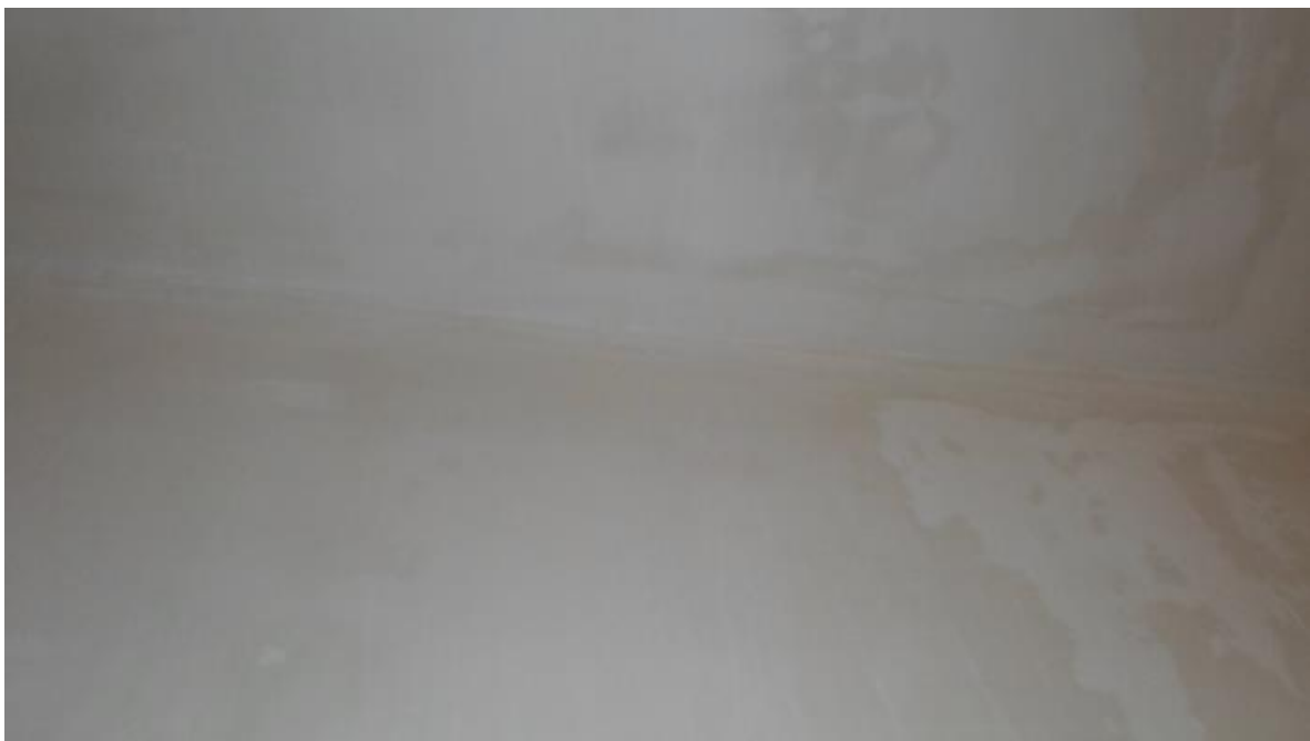
Отслоения шпатлевочного слоя
