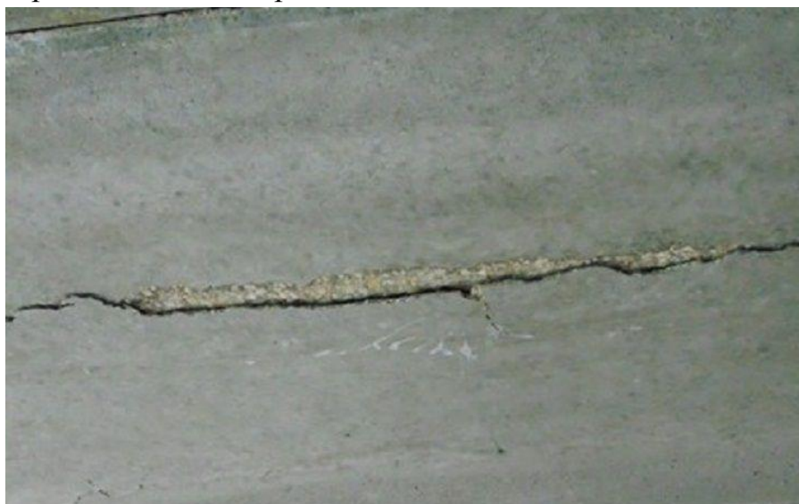
Рисунок 5 – Дефекты плиты перекрытия.
