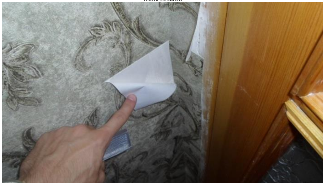
отслоение обойных полотен от поверхности стен на стыках, образование воздушных мешков под обойными полотнами
