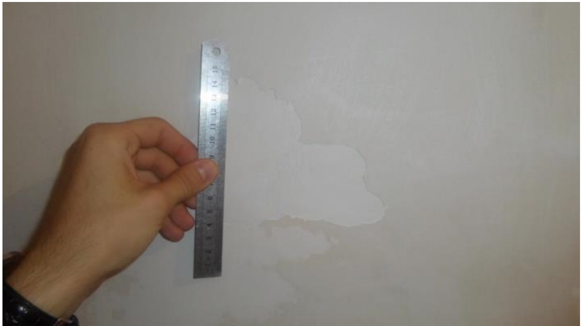
Отслоения шпатлевочного слоя
