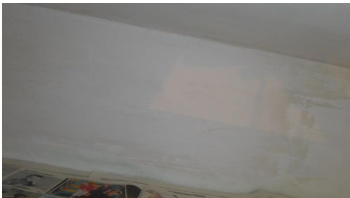
шероховатости, раковины, отслоения шпатлевочного состава, неровности и потеки раствора
